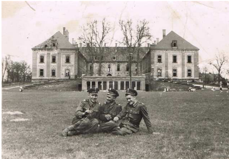
Fig. 3. South elevation of the Palace in Żagań (fot. M. Świątek)
